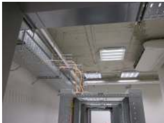
stávající kabelová trasa v serverovně
